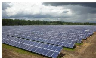
Die Anlage hat ihren Standort in Schönebeck, Sachsen-Anhalt und hat eine Größe von 3,5 MWp. Die Freiflächenanlage ging im Juni 2012 ans Netz. Es wurden beim Bau SolarWorld Module verwendet und Wechselrichter von SMA. Die Anlage erhält eine Eispeisevergütung von EUR 188/MWh. Der Park leistete 1,074 kWh/kWp in den letzten 12 Monaten vor dem Unternehmenszusammenschluss.
