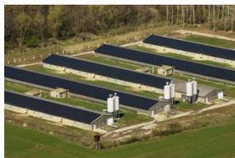
Im Dezember 2007 wurde eine Dachanlage über 1.423 MWp in Landkreis Gotha, Thüringen, Deutschland in Betrieb genommen. Es wurden beim Bau First Solar Module sowie Wechselrichter von SMA verwendet. Die Anlage erhält eine Einspeisevergütung von EUR 482/MWh. Der Park leistete 859 kWh/kWp vom Mai 2015 bis April 2016 vor dem Unternehmenszusammenschluss.
